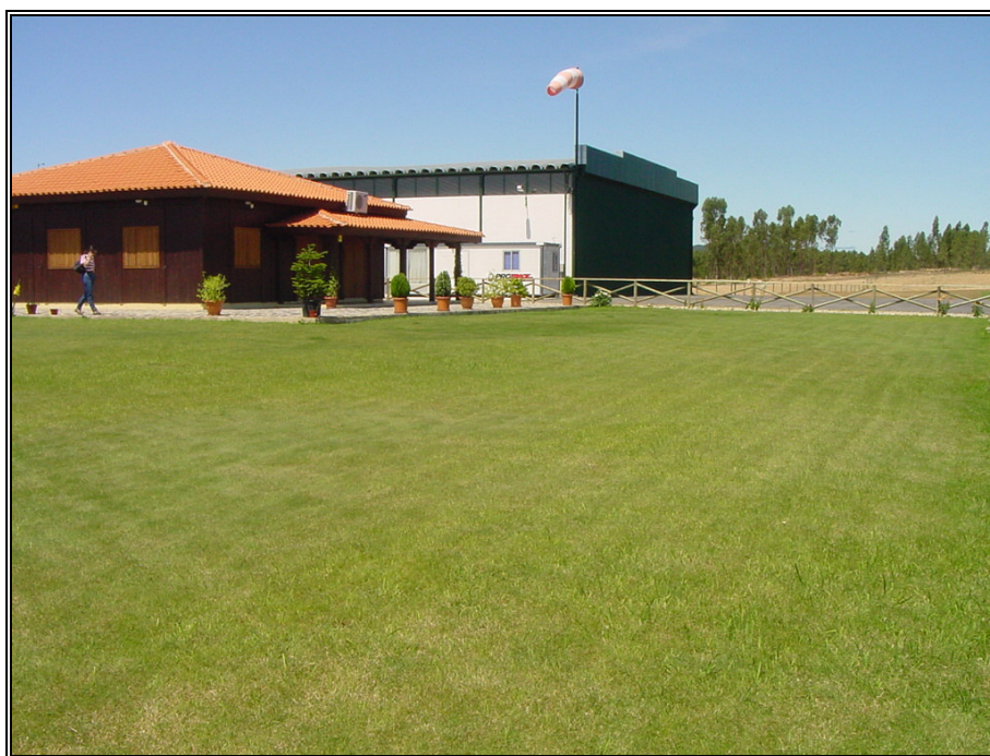
Fotografia 4.12.4 - Centro de Paraquedismo de Moitas
